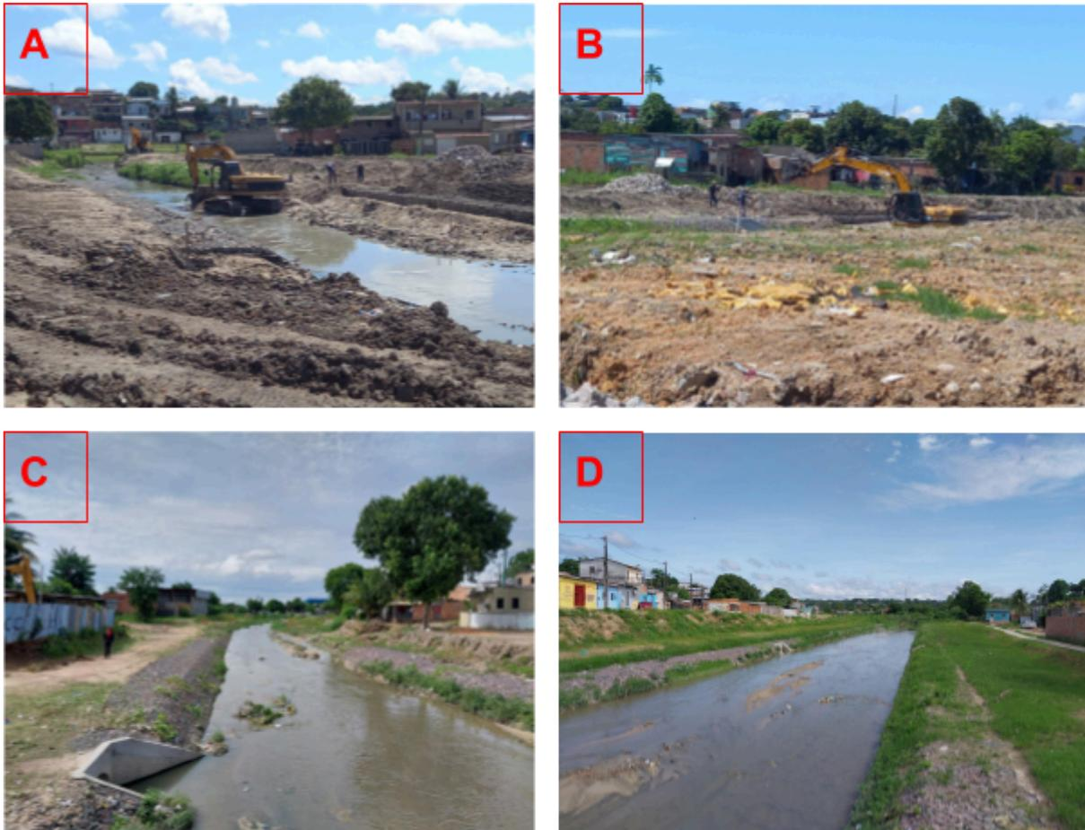
**Figura 26:** Processo da obra da prefeitura no alargamento do canal do Mindu A) processo após retirada de moradores para abertura do canal B) obras em andamento na abertura do canal C) processo finalizado recente com pouca vegetação no entorno e D) alargamento do canal finalizado. (Foto Gabriele F. Santana, 2023).
