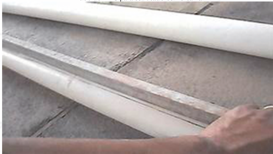
Tubo de PVC para ser usado como calha
