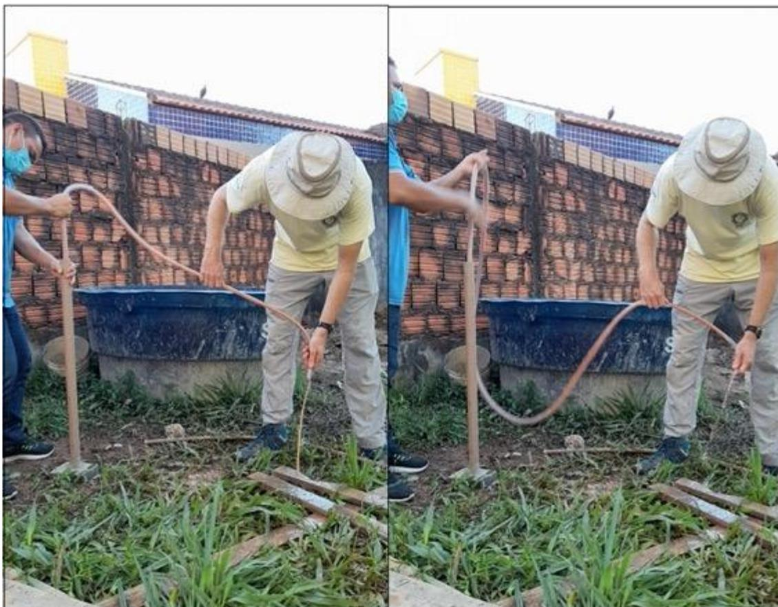
**Figura 8:** Funcionamento de limpeza dos piezômetros para coleta de água.
