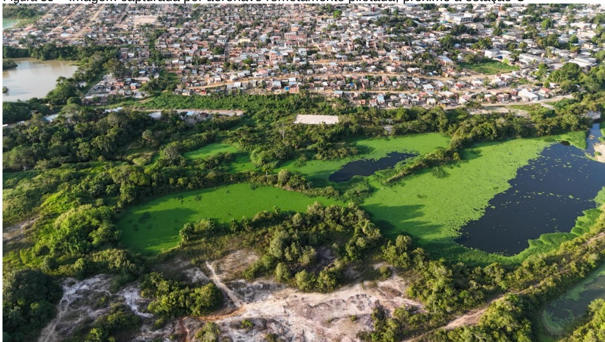
Figura 35 – Imagem capturada por aeronave remotamente pilotada, próximo a estação C
