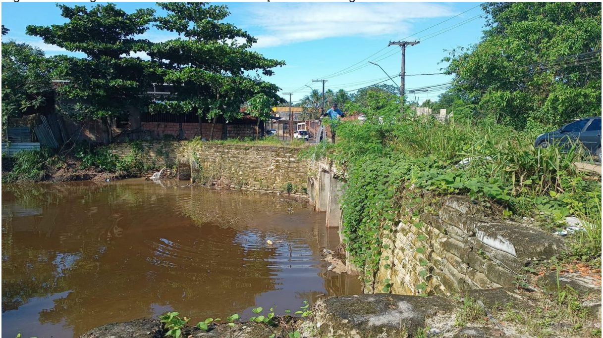
Figura 13 – Registro da última coleta na estação e amostragem A – 13/05/2023
