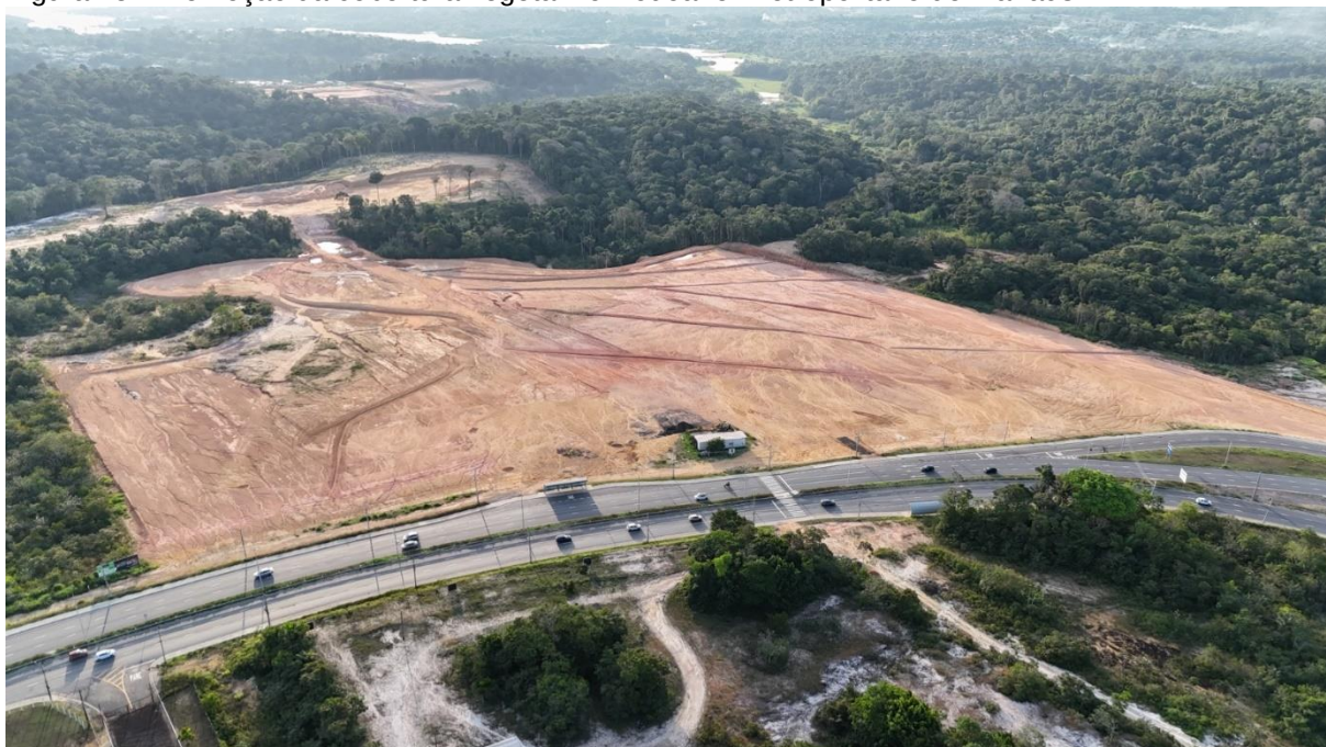
Figura 25 – Remoção da cobertura vegetal no Rodoanel Metropolitano de Manaus
