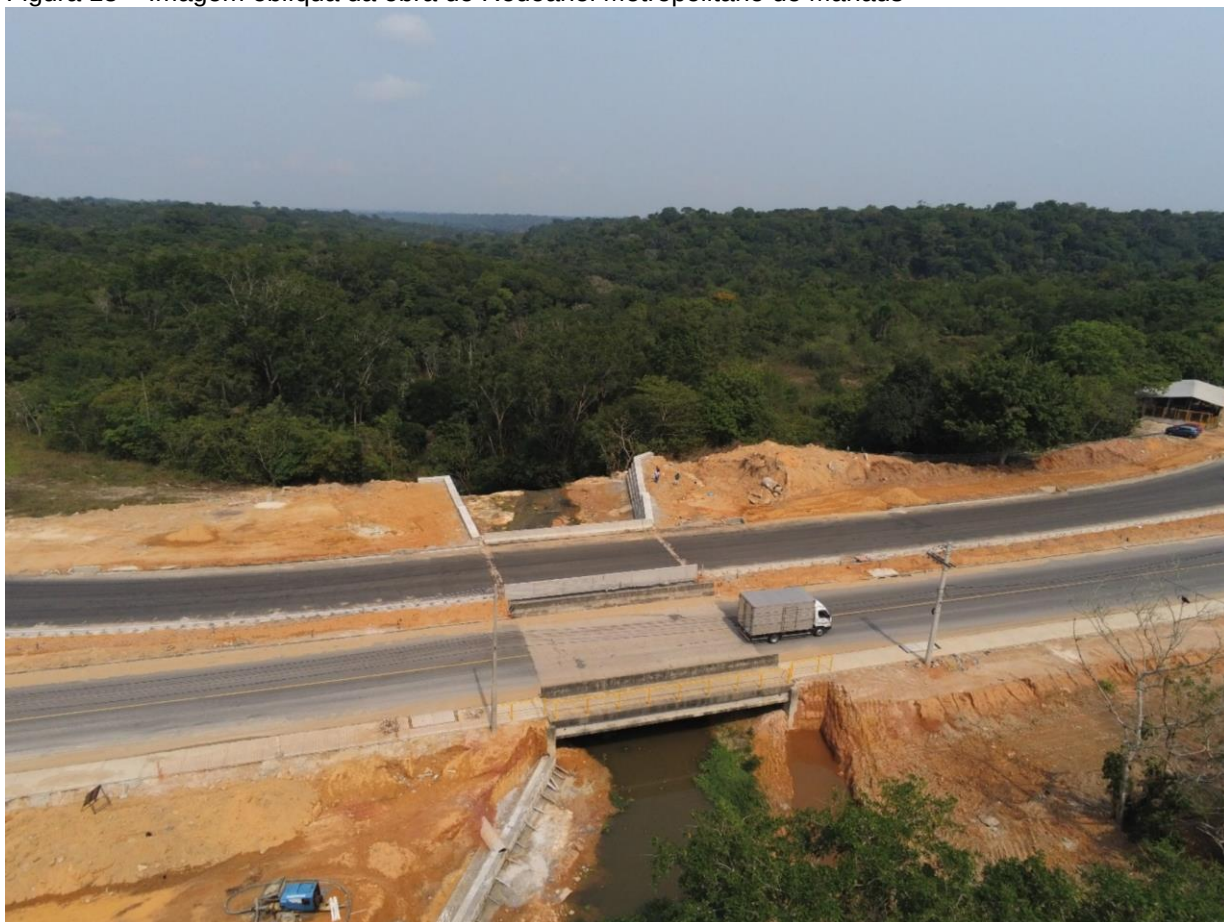
Figura 18 – Imagem oblíqua da obra do Rodoanel Metropolitano de Manaus
