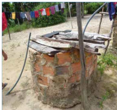
Poço na comunidade Cumarú/Igarapé-Açu/PA (FUNASA, 2017) (imagem 26)
