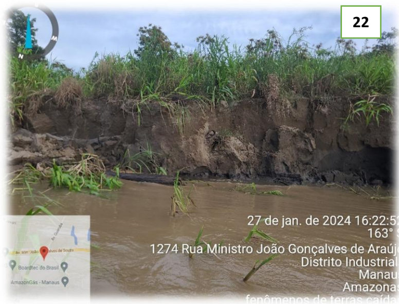
Figura 22: Deslizamento (terras caídas), Costa de terra nova
