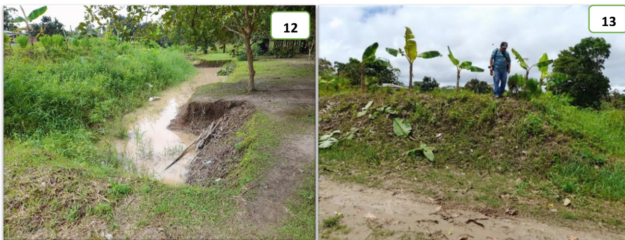
Figuras 12 e 13: local de retirada de aterro para plantação e o próprio aterro de plantação.
