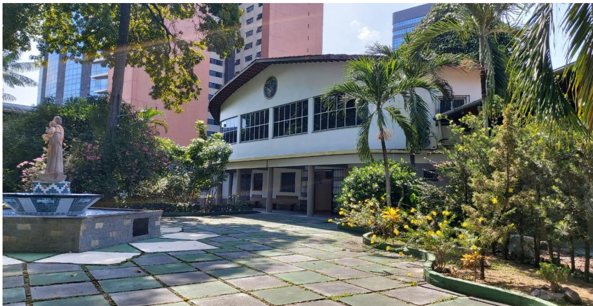
Figura 3: Entrada principal -Seminário São José
