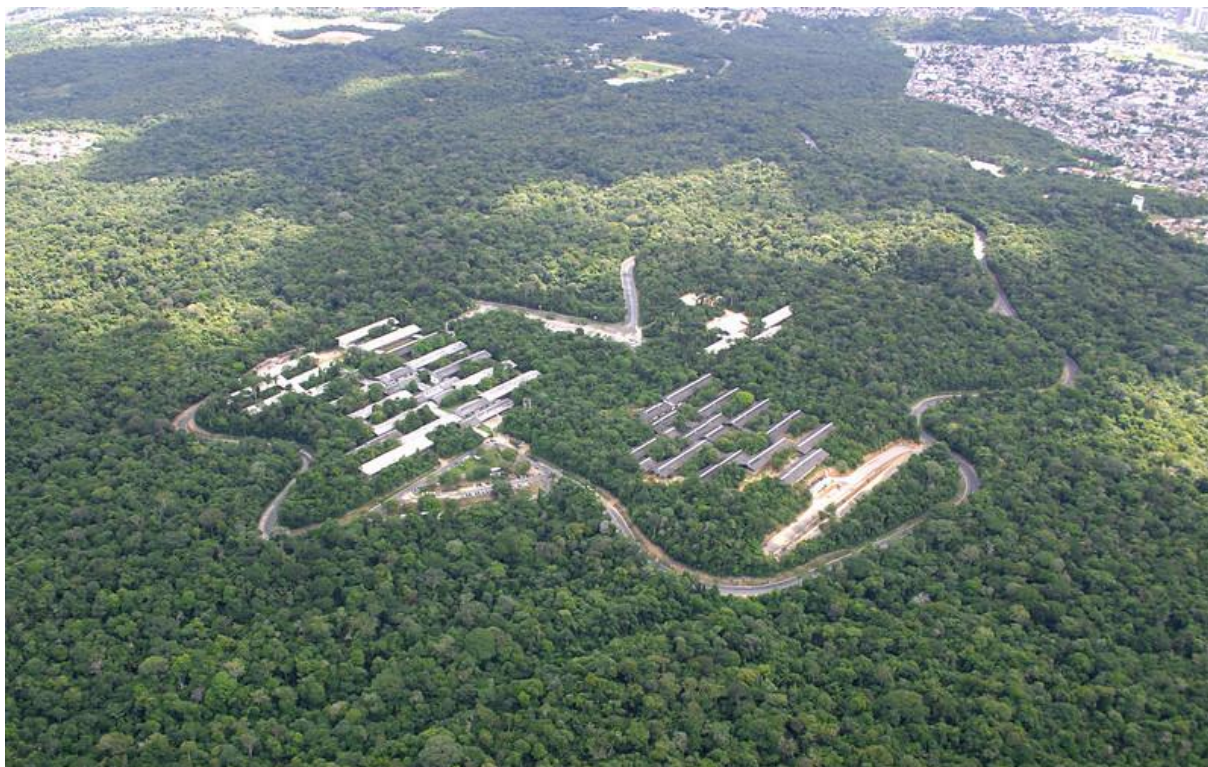
Figura 4 - Campus da Universidade Federal do Amazonas, em Manaus.
