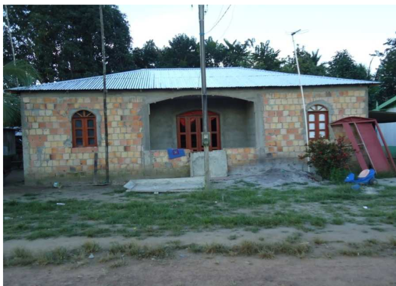
Figura 5. Casa construída de tijolo na comunidade Assentamento Nazaré. Fonte: Marcos Afonso Dutra, pesquisa de campo 2013.
