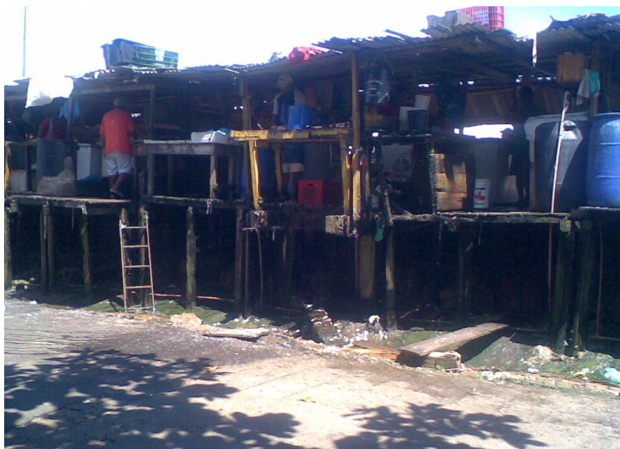
Foto 26: Cenas do porto antes da construção da cobertura.
