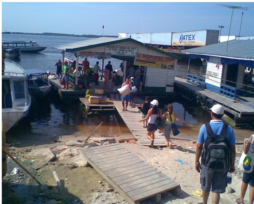
Foto 28: Ancoradouro improvisado no porto da Ceasa.
