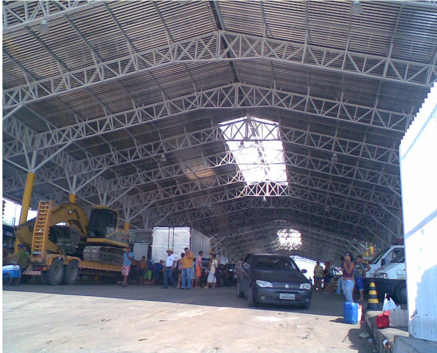
Foto 39: Galpão do porto da Ceasa.
