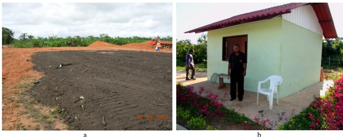
Figura 41. a) Terra preta sobre valas já completadas e pronta para receber cobertura vegetal; b) Guarita de segurança e controle de acesso ao aterro controlado.
