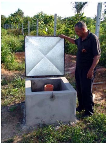
Figura 40. Um dos poços para coleta de amostras de água para verificação de contaminação do lençol freático.
