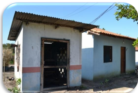
Figura 13 – Abrigo do gerador de energia Fonte – Priscila Rabassa (2012)
