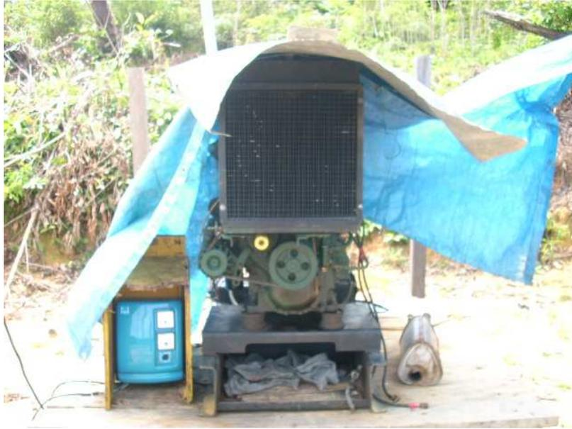
**Figura 27: Gerador de energia sem funcionamento. (Araújo, 2009)**
