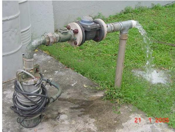
Figura 4.3: Foto de um poço tubular tipo aquífero livre, localizado no Centro
