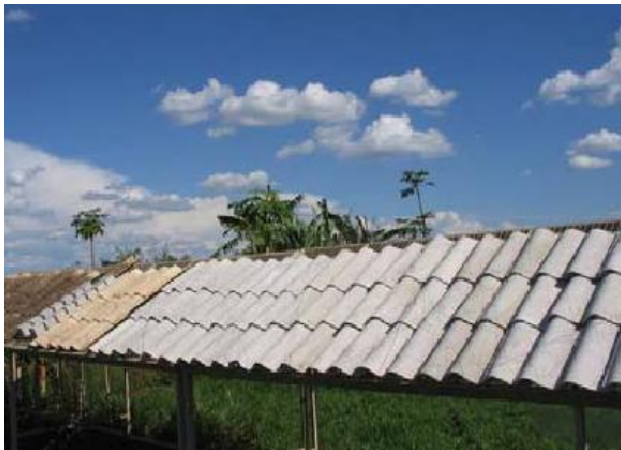
Figura 2.7 – Aplicação em telhas Fonte: TONOLI (2006).
