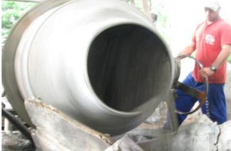
Figura 7 - Mistura do concreto de referência para fabricação da PCP
