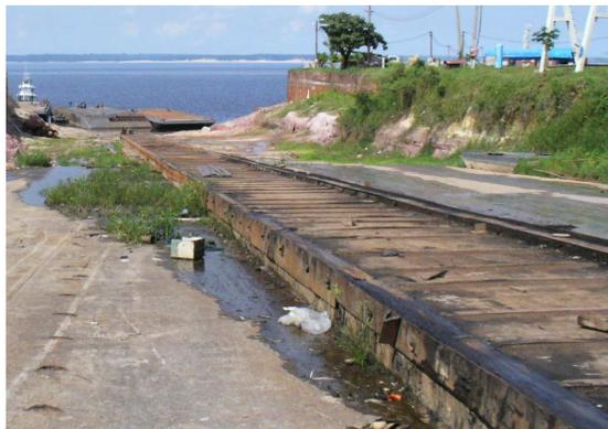
Figura 17: Rampa com 7º de inclinação
