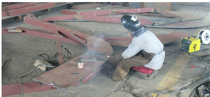
Figura 34: Painel sendo montado
