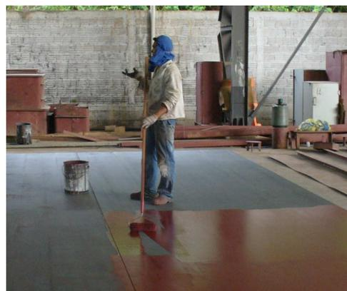
Figura 26 A e B: Pintura da chapa de aço
