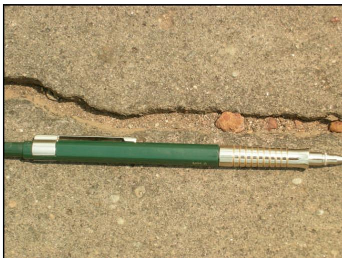
Figura 4.20: Fissuras em pavimento betuminoso, tipo fendas, AM-010.
