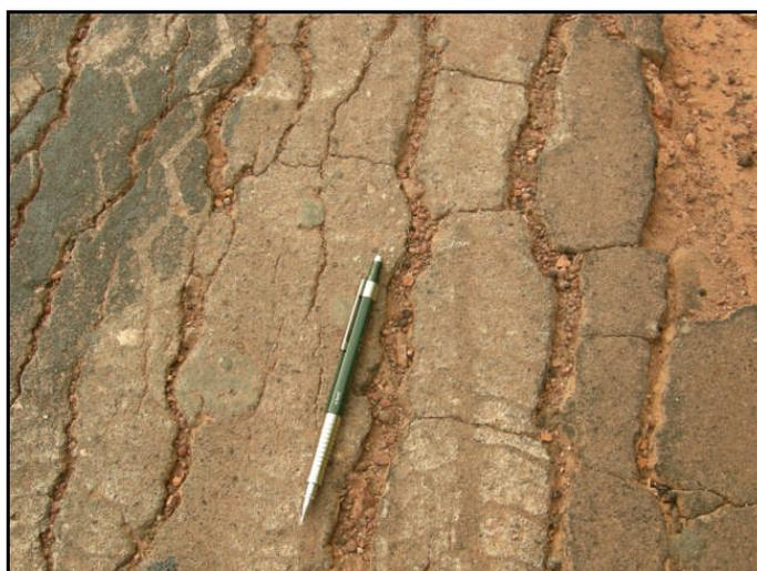
Figura 4.21: Fissuras em pavimento betuminoso, tipo couro de jacaré, AM-010.
