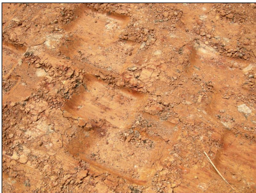
Figura 4.11: Superfície da sub-base preparada para receber a base, com marcas visíveis das patas do rolo compactador.
