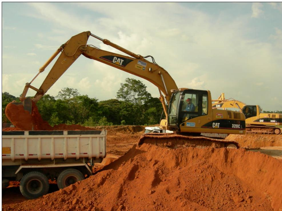
Figura 4.6: Escavação, carga e transporte de material de 1ª categoria.
