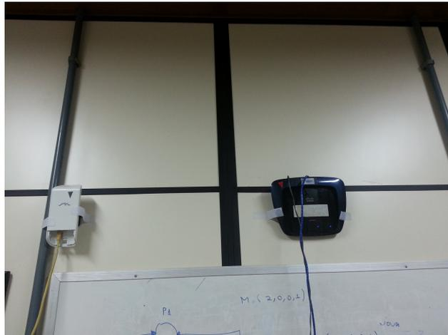
**Figura 5.8.** Organização dos Roteadores Direcionais Espalhados e Omnidirecionais nos Laboratórios.
