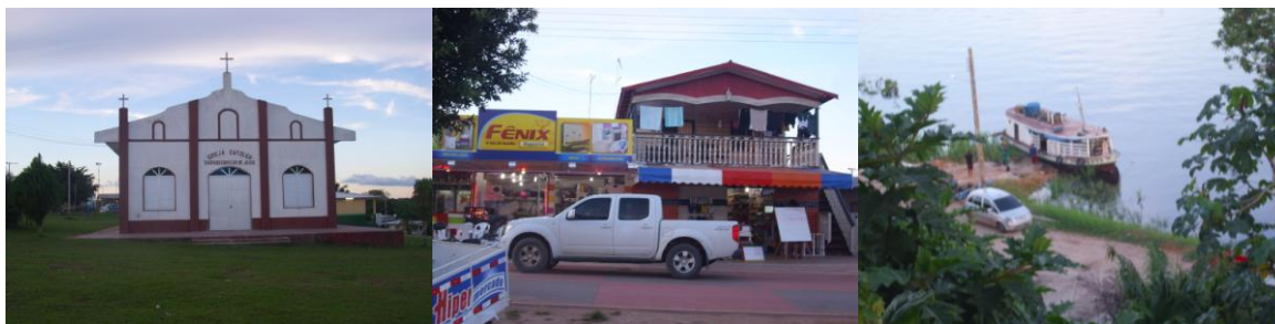
Figura 3: Igreja, comércio e porto fluvial na Vila do Engenho. Itacoatiara/AM, 2012/2013. Foto: Socorro Moraes Nina.
