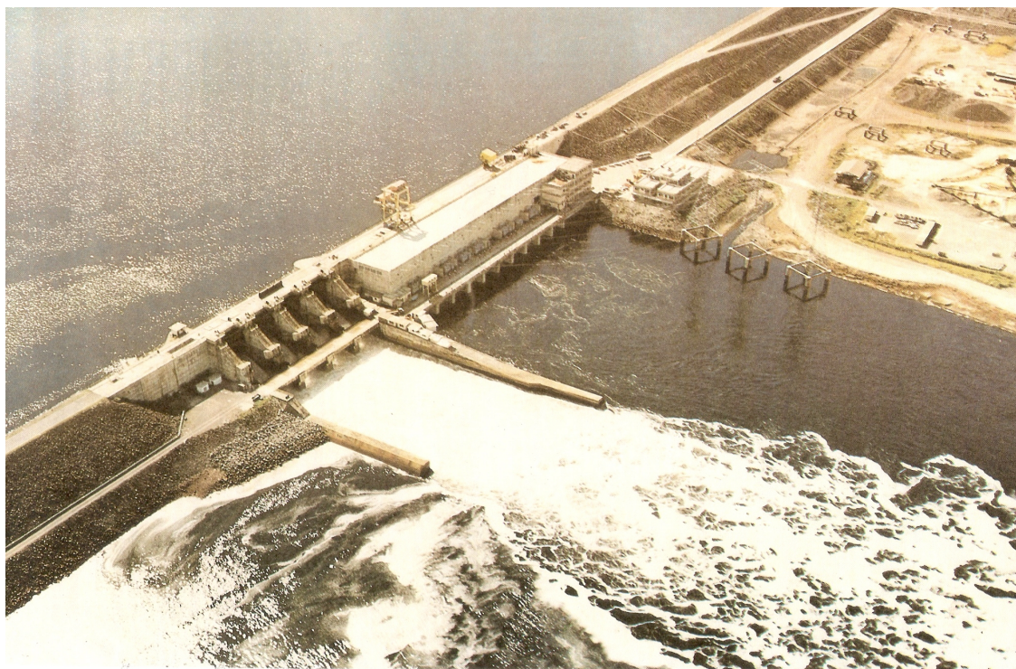
Figura 14 – Vista aérea da UHE Balbina no mês de maio/junho, quando o regime hidrológico do rio Uatumã está na cheia e turbinas da usina estão operando em nível alto. Fonte - UHE Balbina/Memória Técnica, 1997.
