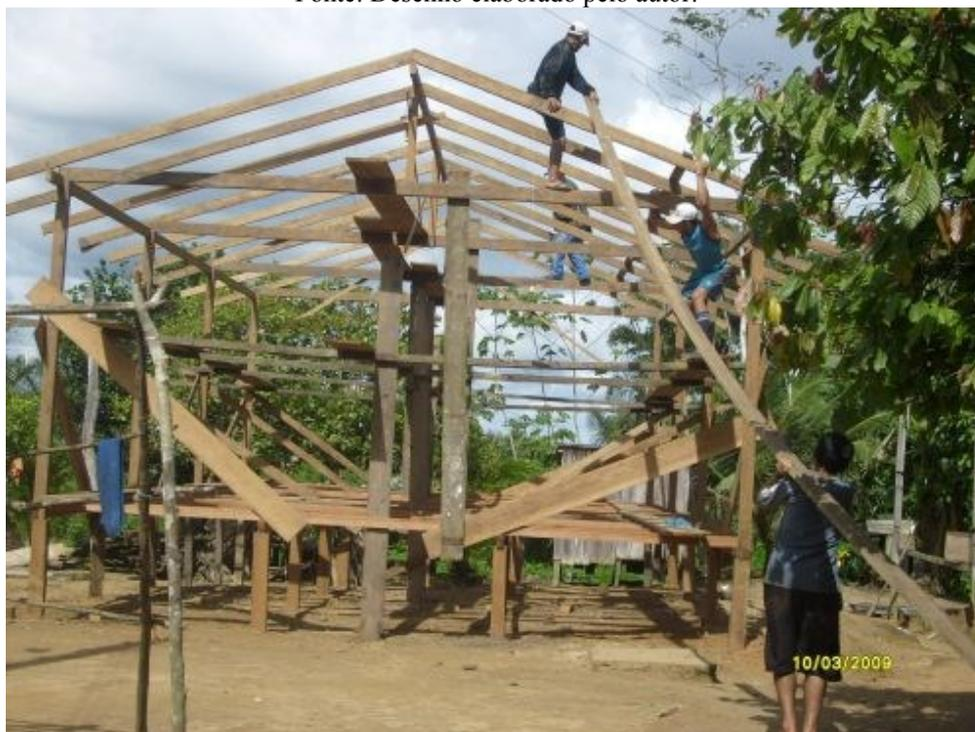
**Figura 29** – Estrutura em madeira do telhado
