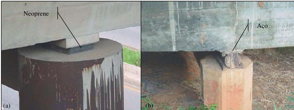
Figura 69 – Exemplos de aparelhos de apoio. (Fonte: Manual de inspeção de pontes rodoviárias – DNIT/2004)
