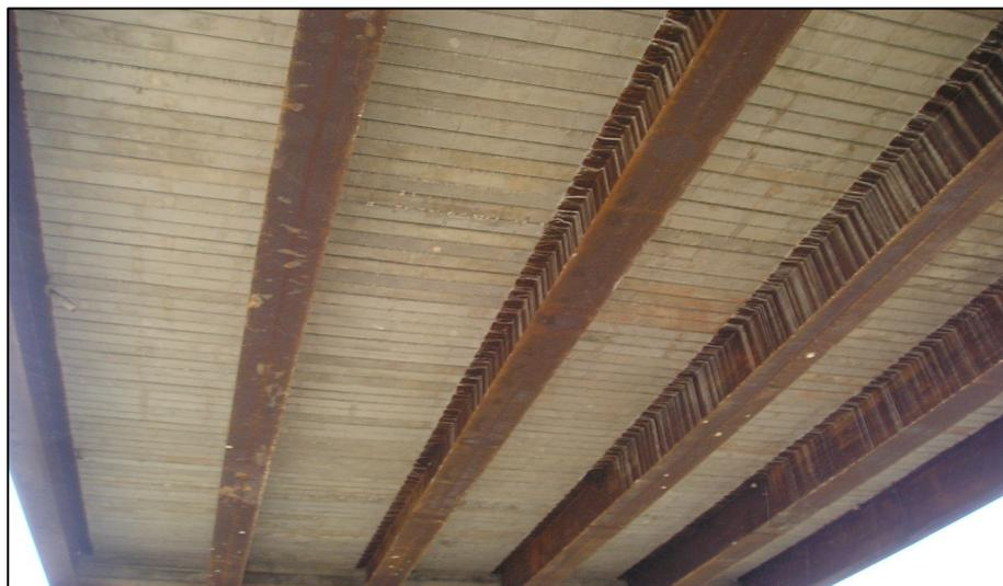
Figura 67 – Estrutura mista com aplicação de pré-moldado na laje de tabuleiro.
