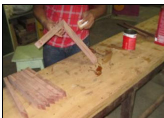
Figura 25. Aplicação de selador nas peças de madeira.
