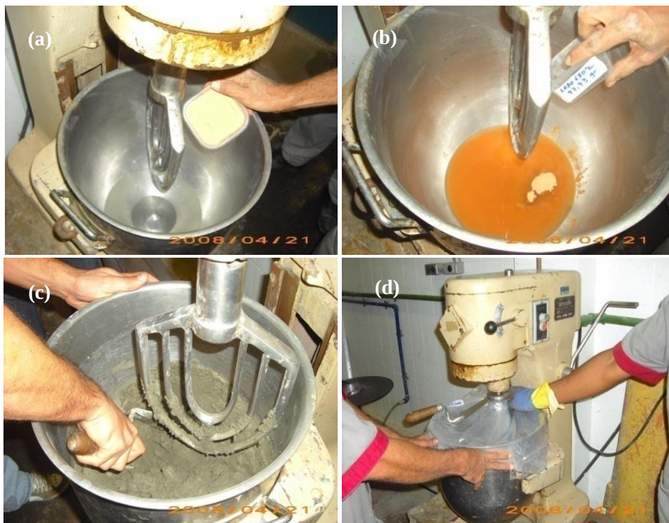
Figura 44: (a) Mistura de água e superplastificante na cuba do misturador; (b) Adição de CLETA na mistura; (c) Retirada de argamassa aderida às paredes da cuba; (d) Mistura em repouso para manter a umidade.
