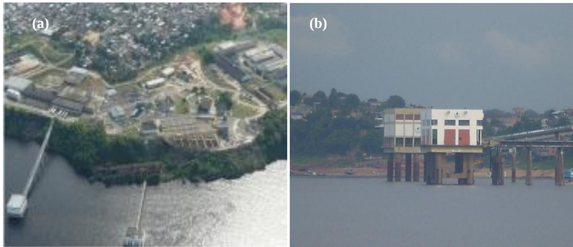
Figura 8: (a) Vista das estações elevatórias da Ponta do Ismael; (b) Estação elevatória.
