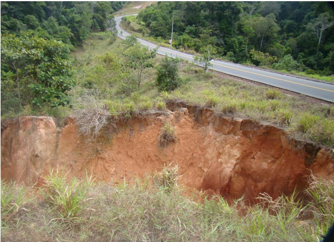
**Figura 32:** Voçoroca com mensuração de risco a curto prazo na AM-363, km-68 (Setembro de 2013).
