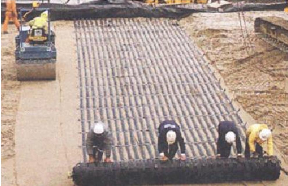
Figura 1 - Camada de solo compactado intercalada por geogrelha.
