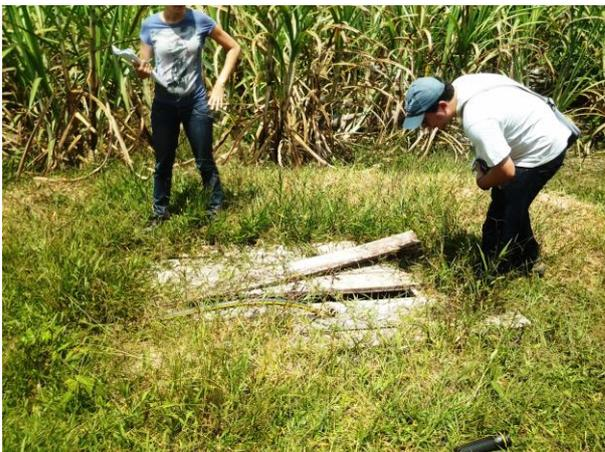
Figura 20 - Cacimbão em terreno plano sem mureta e tampa de madeira com frestas
