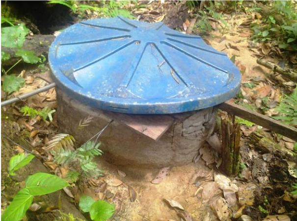
Figura 18 - Cacimbão com mureta de tijolos e tampa plástica
