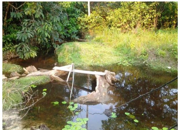
Figura 21 - Captação de água do igarapé
