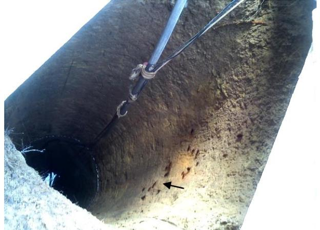
Figura 17 - Cacimbão sem revestimento interno com presença de baratas
