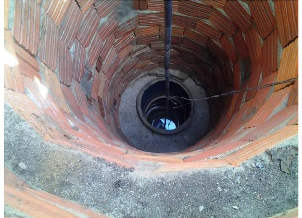
Figura 19 - Cacimbão com revestimento interno
