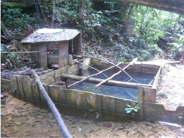
Figura 22 - Captação de água de nascente
