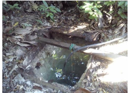
Figura 27 - Cacimbão sem revestimento e proteção externa localizada na mata
