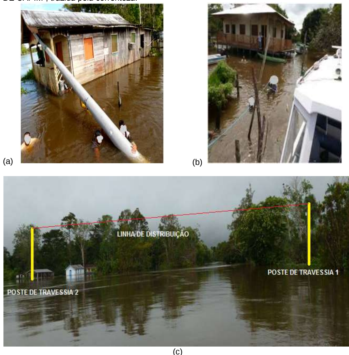
Figura 30 – Instalação de poste após queda ocasionado por choque de objeto, uma “BOLA DE CAPIM”, trazida pela correnteza.
