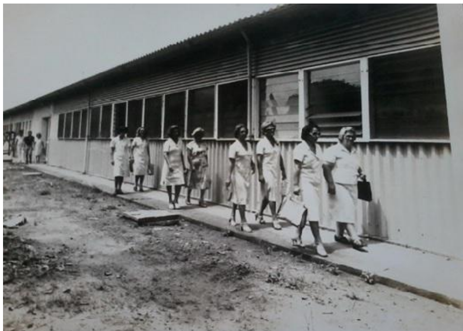
Figura 6 – Sra. Armine Lindoso (à frente, a direita), esposa do ex-governador José Lindoso em visita a obra do pavilhão do CECON onde seria instalada a radioterapia e as enfermarias. – Maio/1979.
