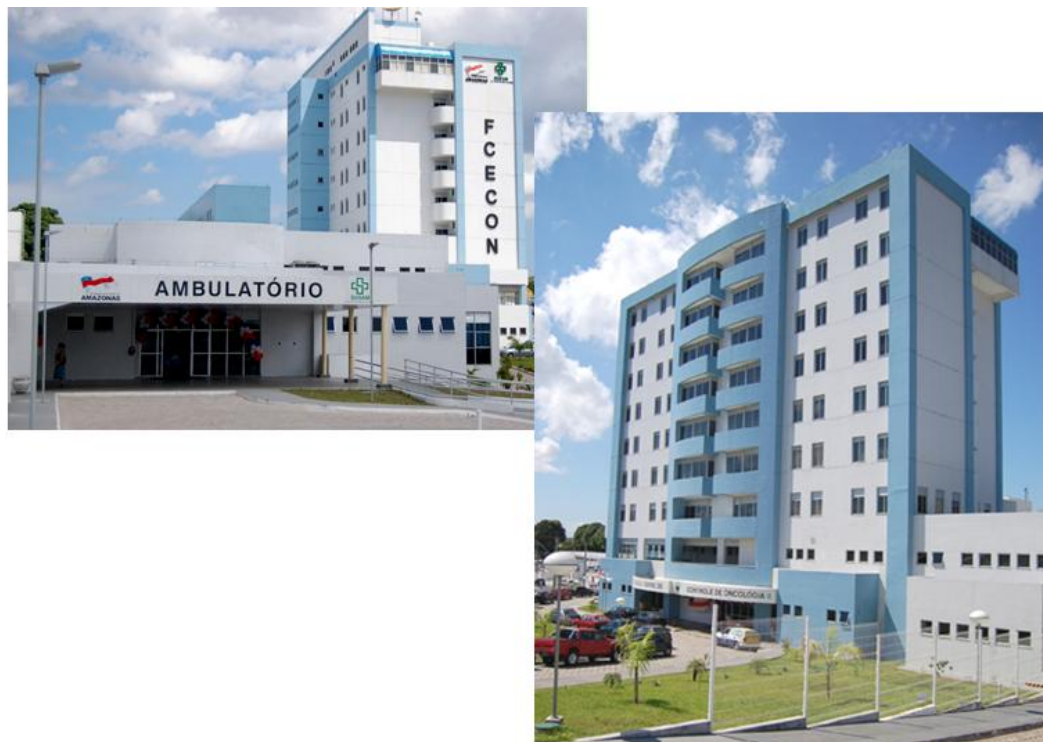
Figura 9 - Instalações inauguradas em 2006.
