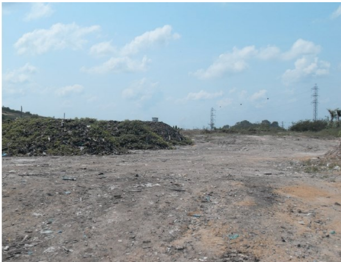
Fig. 8: Ausência de sistema de drenagem de águas pluviais
