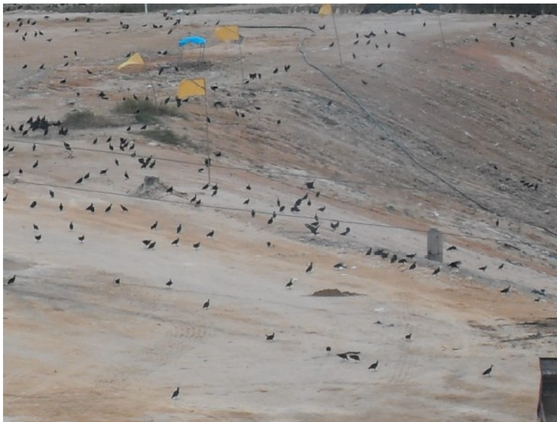
Fig. 4: Ausência de recobrimento propícia a presença de animais, aumentando o risco aviário Fonte: Relatório de Auditoria Operacional realizada no Programa de Governo “Manaus mais Limpa”, na área de Resíduos Sólidos Urbanos – RSU 2010
