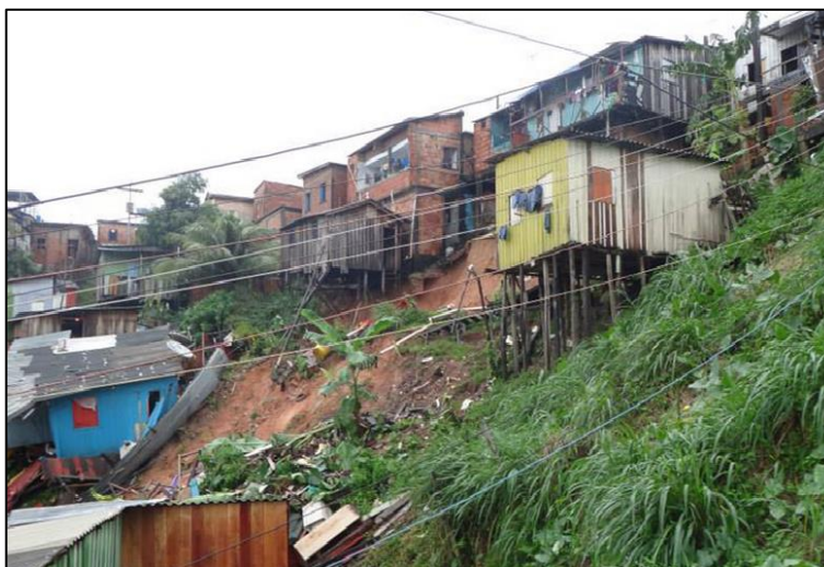
Figura 5 - Casas em Manaus que desabaram no período de chuvas.
