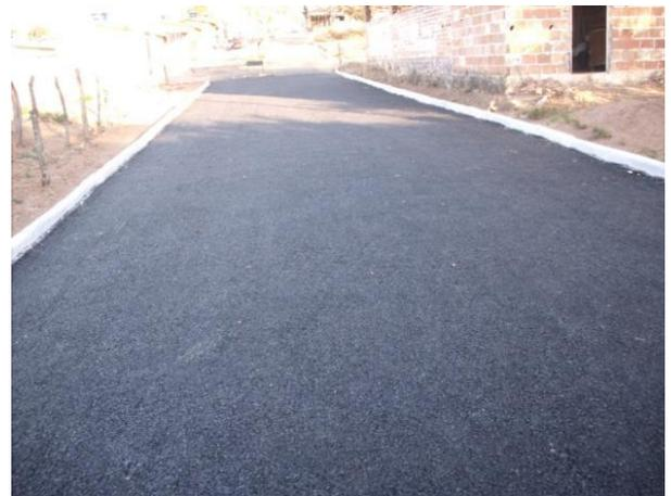
Figura 20 – Vista Geral do Primeiro trecho Experimental Realizado com PMF Contendo Agregados de Ardósia. Fonte: Rodrigues (2011).
