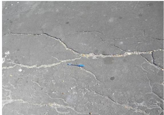
Figura 4 – Trincas longitudinais.
