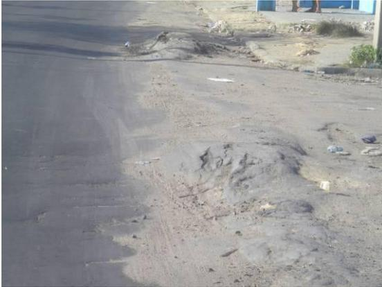
Figura 7. Afundamento de trilha de roda com nível de deterioração alto.
