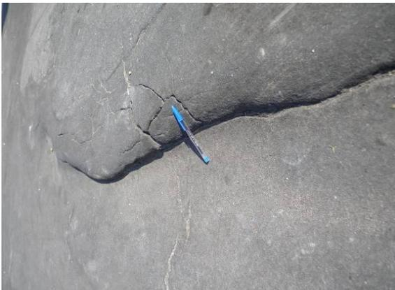
Figura 5 – Escorregamento do revestimento (AAUQ).
