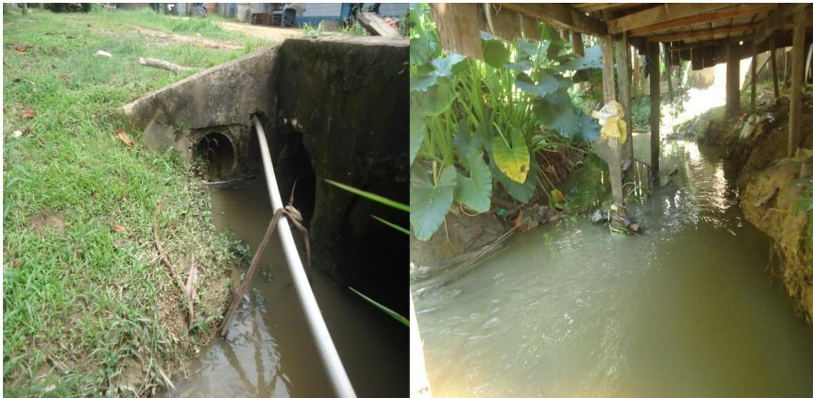
Figura 26: Escoamento de rede de esgoto e construção de palafitas sobre o leito do igarapé
