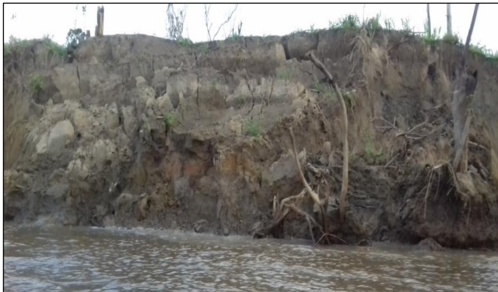
Figura 8 – Erosão Fluvial na comunidade Nossa senhora da Paz
