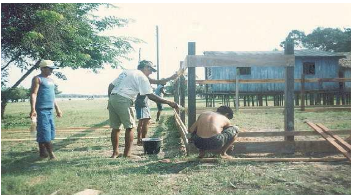
Figura 9. Construção da chocadeira próxima às comunidades
