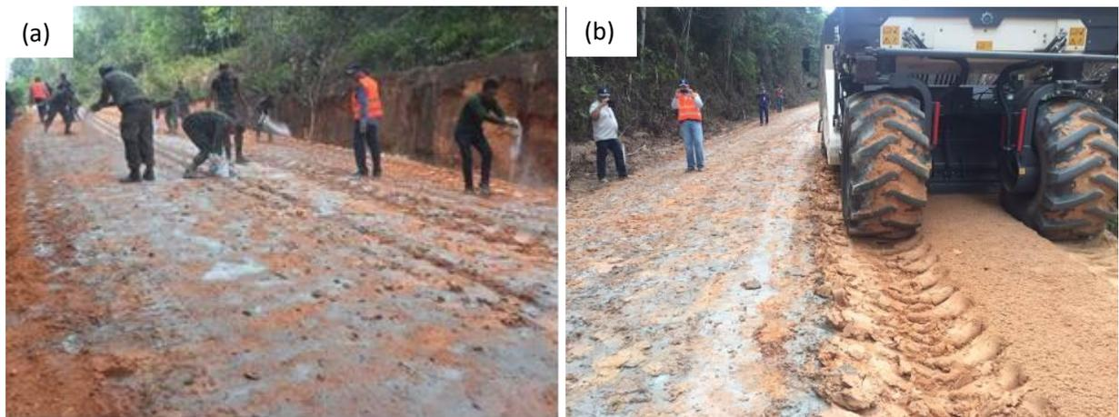
Figura 55 Espalhamento manual do RC (a) e homogeneização com solo *in situ* utilizando-se de recicladora (b).
