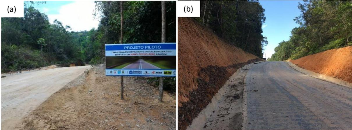
Figura 57 Aspecto final da seção teste com 1 dia de conclusão em 10/16 (a) e após 490 dias em 02/18 (b).
