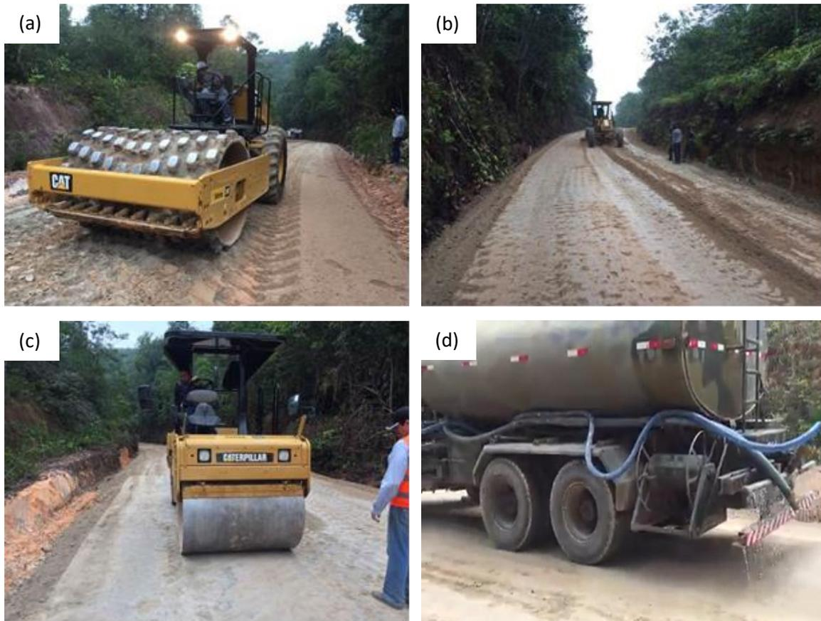
Figura 56 Etapas de compactação (a), abaulamento (b), acabamento final (c) e cura (d). (Fonte: Própria, 2016)
