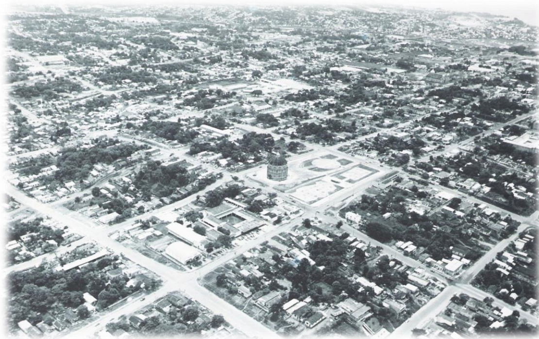
Foto 01: Vista panorâmica da Praça Quatorze de Janeiro nos anos 1970
