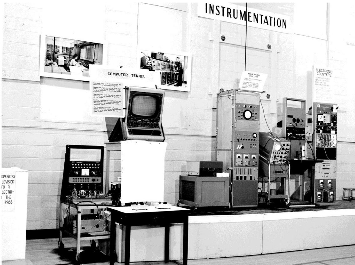
**Figura 5:** O experimento com a tela de osciloscópio e os controles exibido no ginásio de Brookhaven. *Tennis for Two* é o segundo equipamento da esquerda para a direita. O protótipo foi exibido por três dias em dois anos diferentes e mais tarde foi mantido como uma reprodução para celebrar a invenção de Higginbotham
