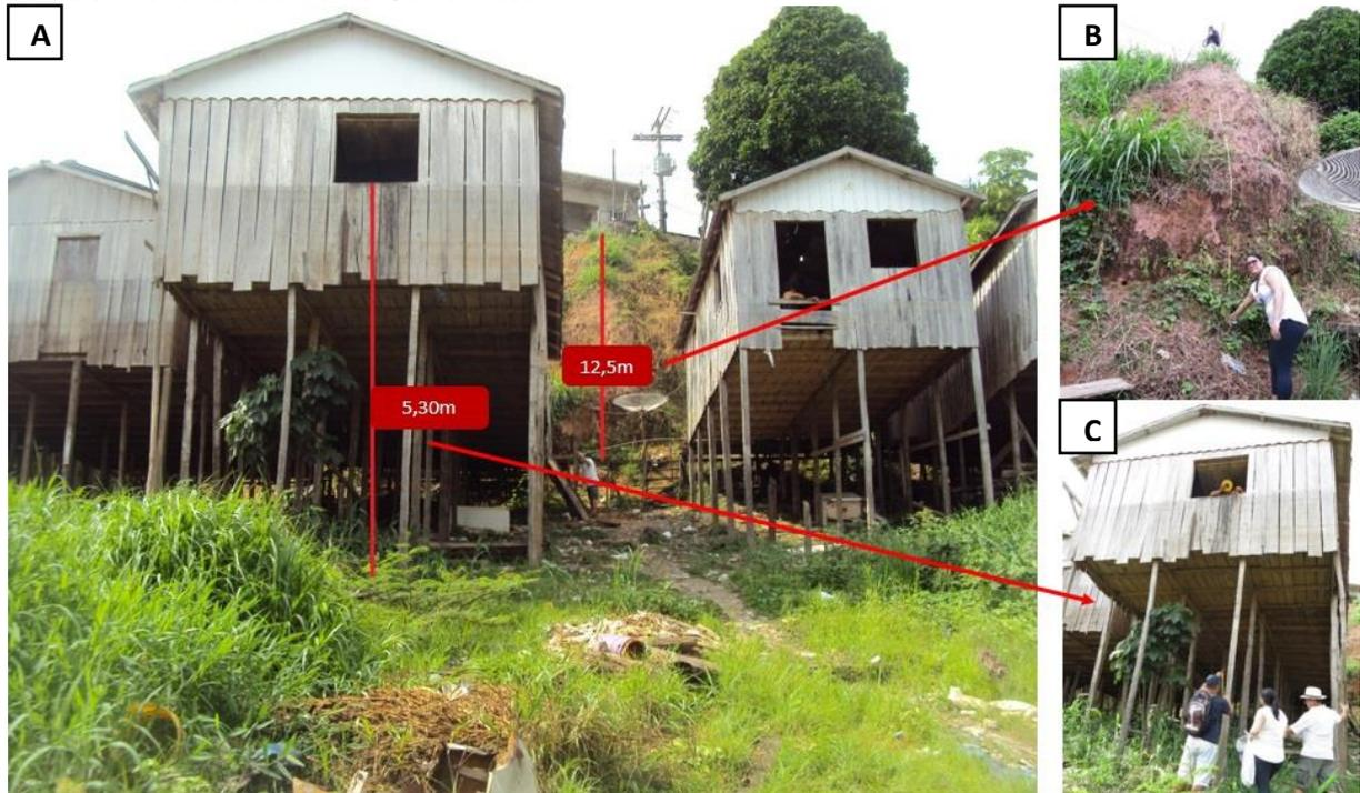
Fonte: SILVA, A. C.C. 2016. A- Marca d'água; B- Medição da altura do nível do barranco, Foto: SOUZA, I. M. A. 2016; C- Medição do nível do rio na janela da casa. Foto: SOUZA, I. M. A, 2016.
