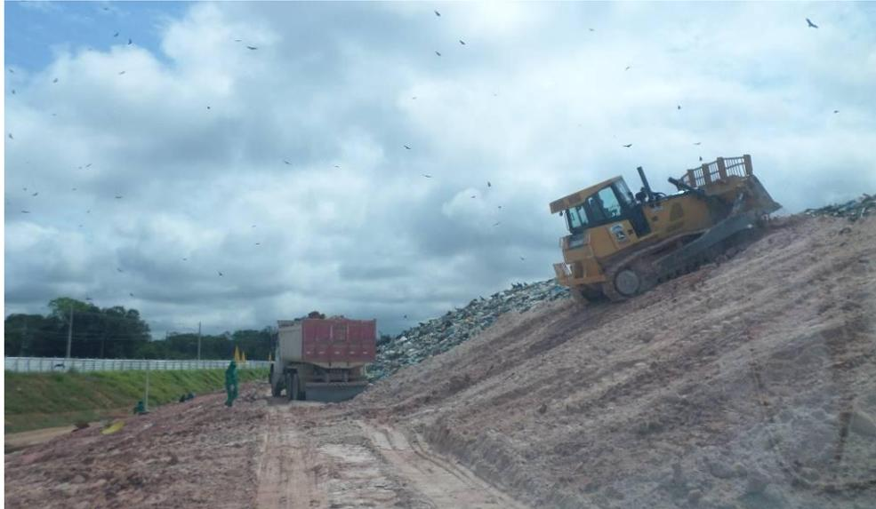
**Figura 14:** Recobrimento dos resíduos dispostos para aterramento no âmbito do aterro municipal de Manaus, onde após a disposição e compactação dos resíduos este é recoberto com uma camada de argila para posteriormente haver um novo aterramento após a impermeabilização.
