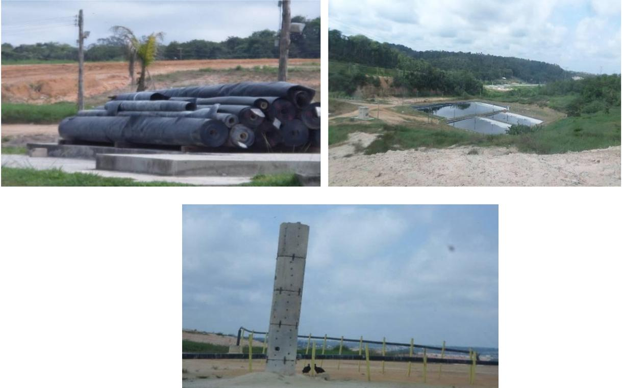
**Figura 13:** Manta impermeabilizada, lagoa de decantação de chorume e tubulação de queimadores de gases produzidos no âmbito do aterro.
