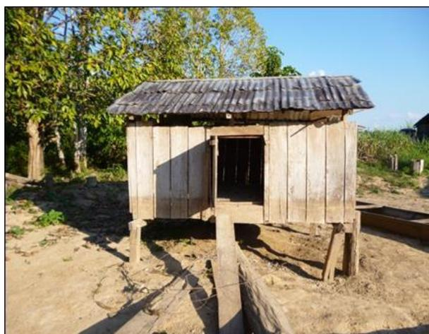
Figura 80 - Galinheiro construído em madeira e coberto por telha de alumínio para proteção dos animais no período de cheia podemos ver, na parte inferior, a marca do alcance da água, na cheia de 2015
