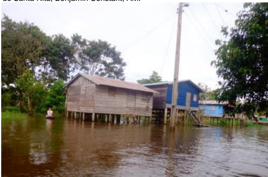
Figura 4 - Casas construídas acima do nível de enchente na Comunidade de Santa Rita, Benjamin Constant, AM.
