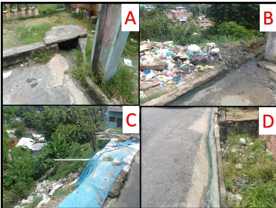
A figura 08A, mostra o final da rua F a entrada do bueiro, onde o escoamento superficial é concentrado e seguem em direção do fundo do vale. A imagem da figura 08B mostra o acúmulo de lixo no final da rua paraíso, em uma área localizada nos limites da bacia, onde ocorreu um deslizamento de terra nas proximidades de terrenos destinados a Marinha do Brasil.
