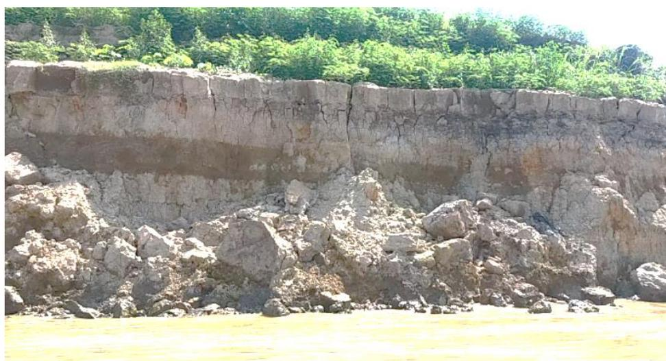
**Figura 45:** Outro possível talude representativo, haja vista a distribuição de ao menos três tipos de solo, com destaque a argila vermelha que se propaga de maneira contínua nesta parte da margem.
