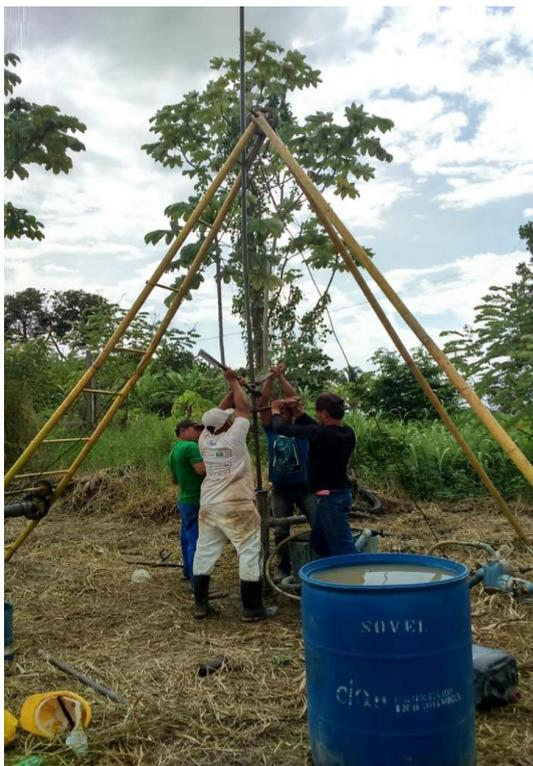
**Figura 65:** Equipe de sondagem à percussão para investigação da disposição e resistência dos solos componentes do maciço.
