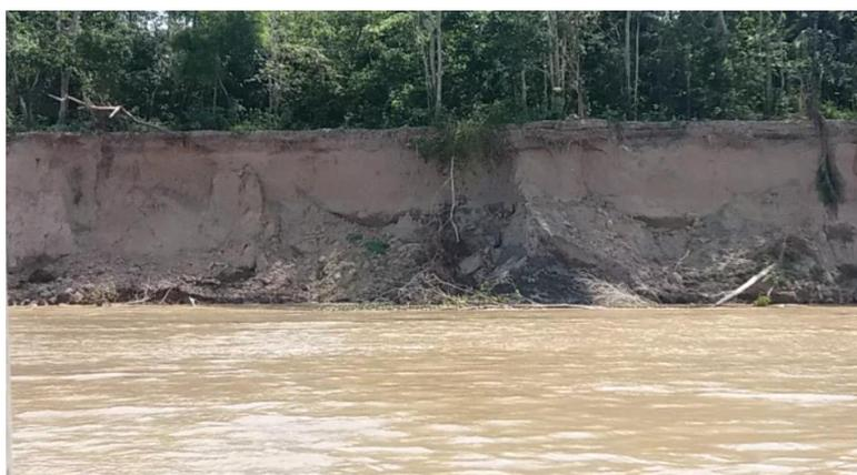
**Figura 37:** Margem afetada pelo fenômeno. Conforme notícia, a mesma sofreu o desmoronamento na noite anterior à visita técnica.
