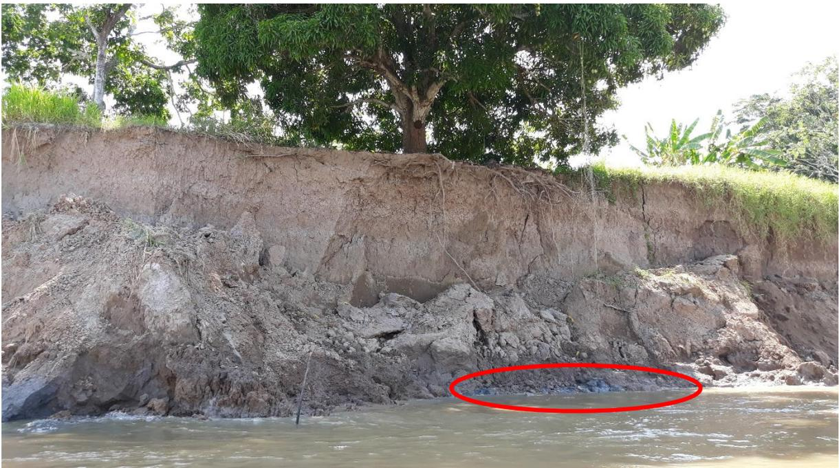
**Figura 53:** Ocorrência do desabamento. Uma parte do maciço se mantém em balanço pela ação da vegetação e da coesão do solo constituinte. Alguns traços do solo “Cinza” já são notados, porém o nível do rio não permite ainda alcançá-lo.
