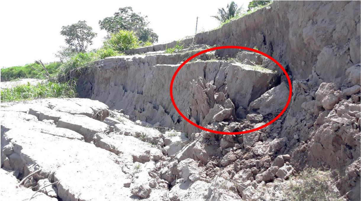
**Figura 52:** Visão do bloco desmoronado por dentro. Observa-se a presença marcante do solo dito “Mosqueado” (levemente avermelhado) com bolsões arenosos.
