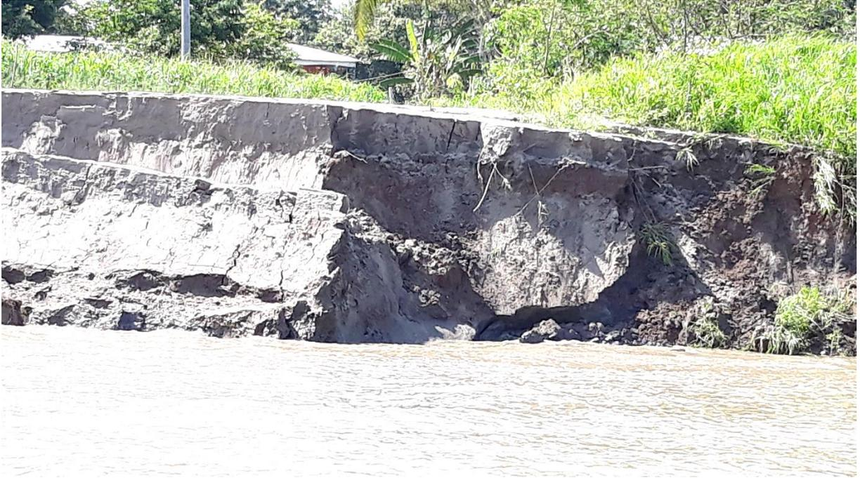
**Figura 49:** Blocos fruto de desmoronamento dos solos “Mosqueado” e “Areia”. Nestes já se observa a ocorrência dos desmoronamentos, com a formação dos blocos de aspecto irregular.
