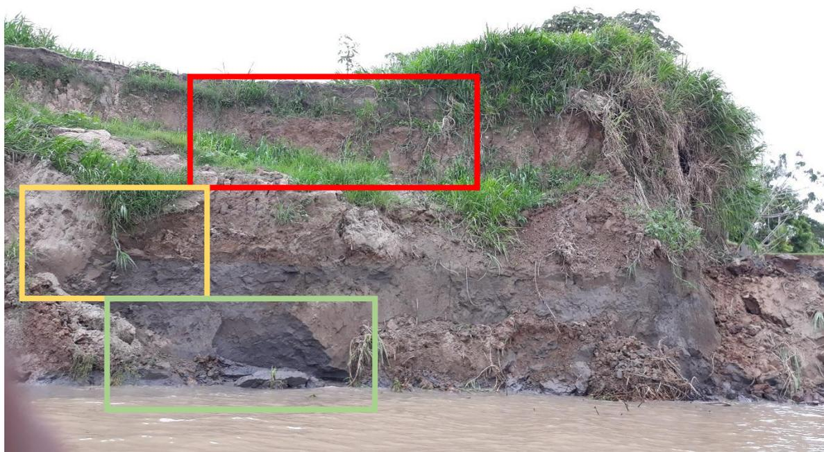
**Figura 58:** Observação do maciço representativo. Neste, há a presença das três camadas que este estudo se propõe caracterizar, sendo vermelho para o solo “Mosqueado”, amarelo para o solo “Areia” e verde para o solo “Cinza”.
