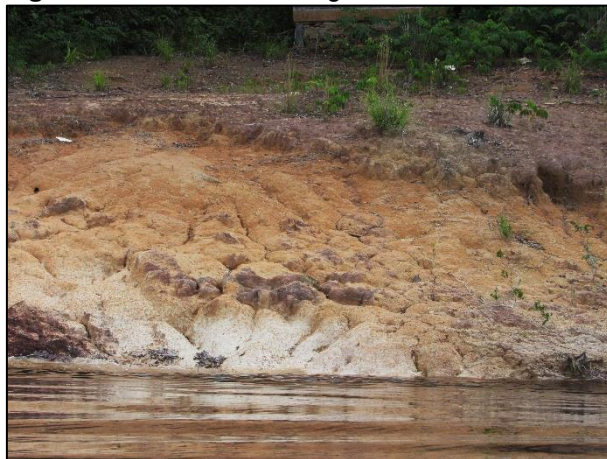
Figura 38 – Erosão na margem.
