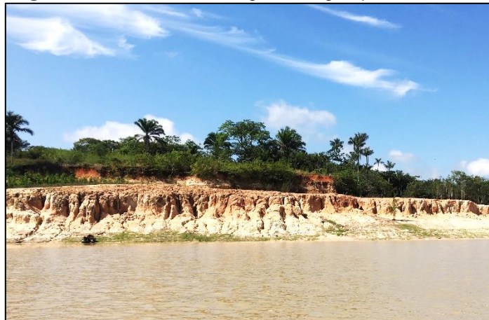
Figura 45 – Erosão nas margens do igarapé Cantonicha.
