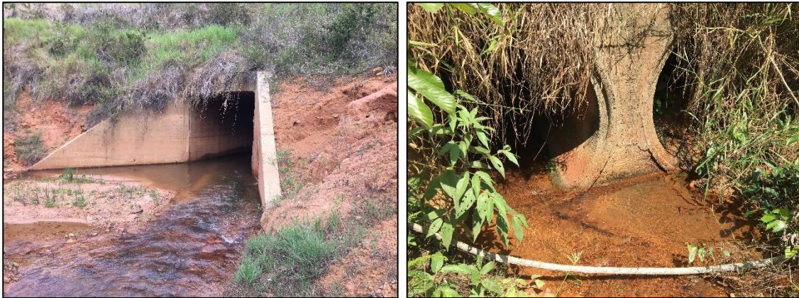
Figura 13 – Canalização do igarapé Chico preto. Figura 14 – Canalização do igarapé do Km 9.
