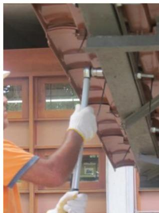
Figura 7 - Torquímetro sendo utilizado para aplicação de tensionamento nas terças. Fonte: GÓES (2015).
