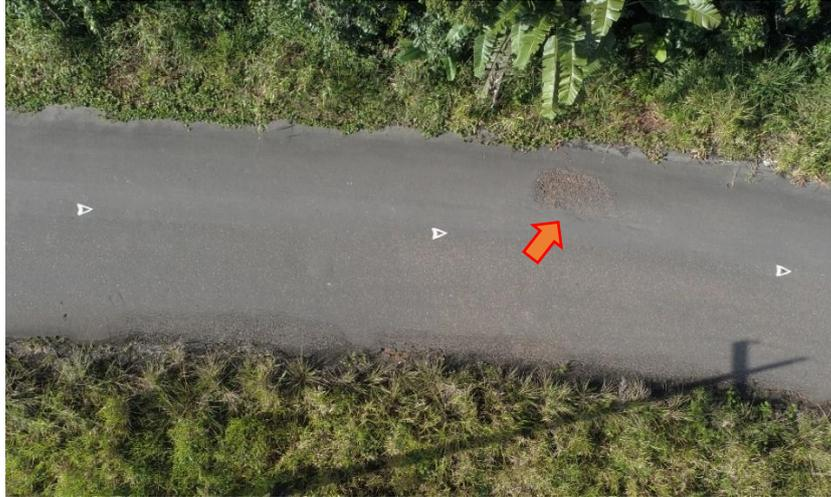
Trincas Interligadas tipo “Jacaré” com erosão nas bordas e Ondulações
