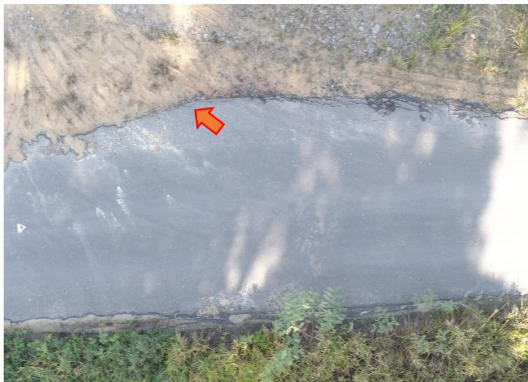
Panela ou buracos decorrentes da desagregação do revestimento
