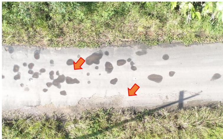
Desgaste acentuado na superfície do revestimento
