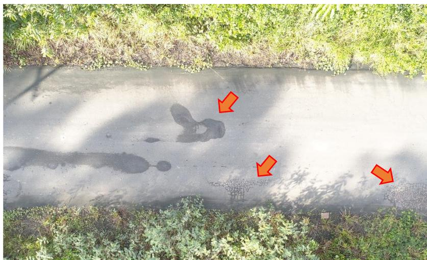
Trincas Interligadas tipo “Jacaré” com erosão nas bordas
