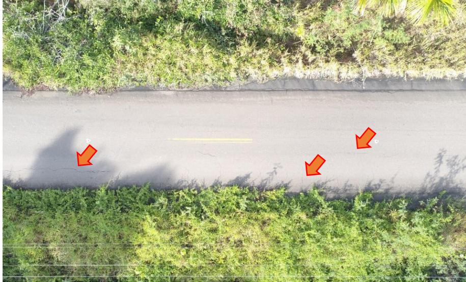
Trincas Isoladas Transversais Longas e Trincas interligadas tipo “Jacaré”
