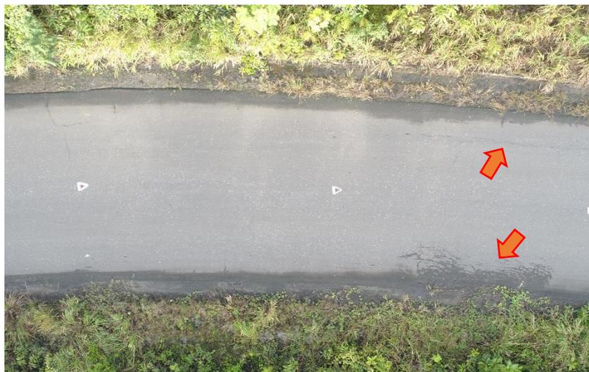
Trincas interligadas tipo “Jacaré” e Escorregamento do revestimento
