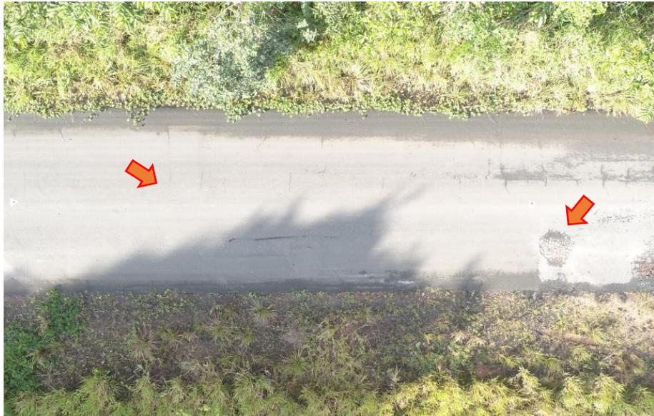
Trincas Isoladas Longitudinais Longas e Afundamento Plástico da trilha
