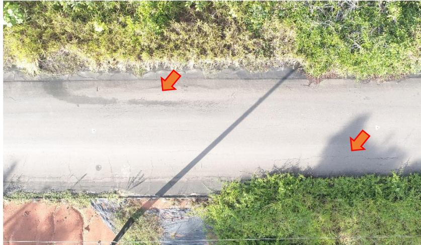
Afundamento Plástico Local e Trincas Isoladas Longitudinais Longas
