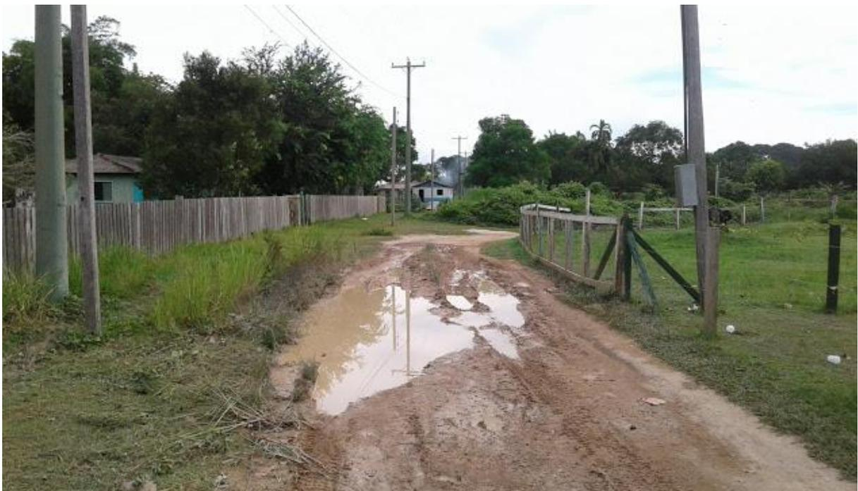
Figura 30: Falta de escoamento de água.
