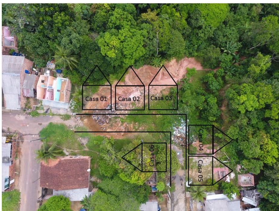
Figura 27 - Voçoroca 5, destacando as vias e casas destruídas
