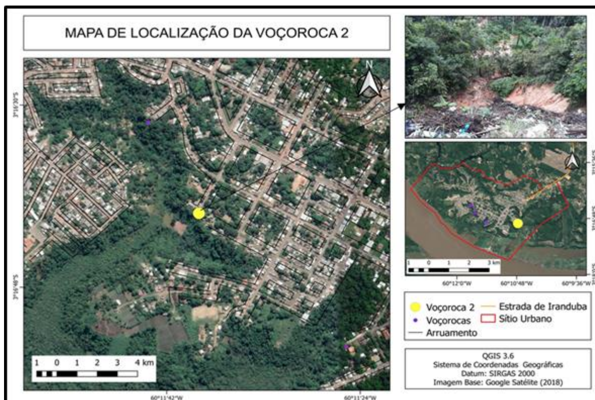
Figura 12 - Localização da voçoroca 02
